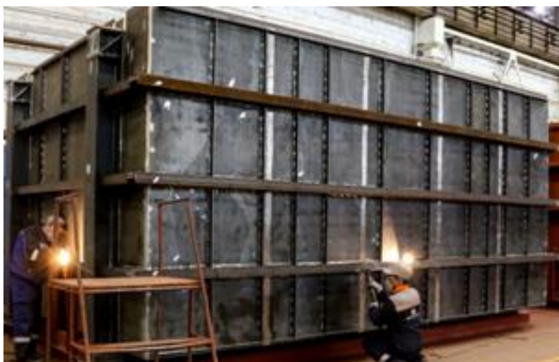
Рис. 4. Изготовление энергетической котельной установки [8]
