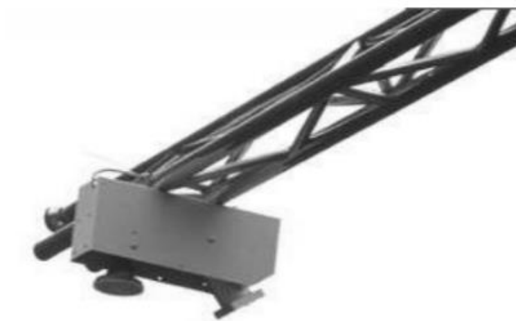
Рис. 5. Установка системы измерения на конструкциях моста
