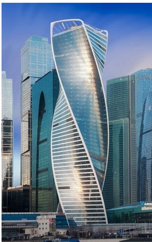
Рис. 5. Башня «Эволюция» (255 м, 2011 – 2014 гг.).
