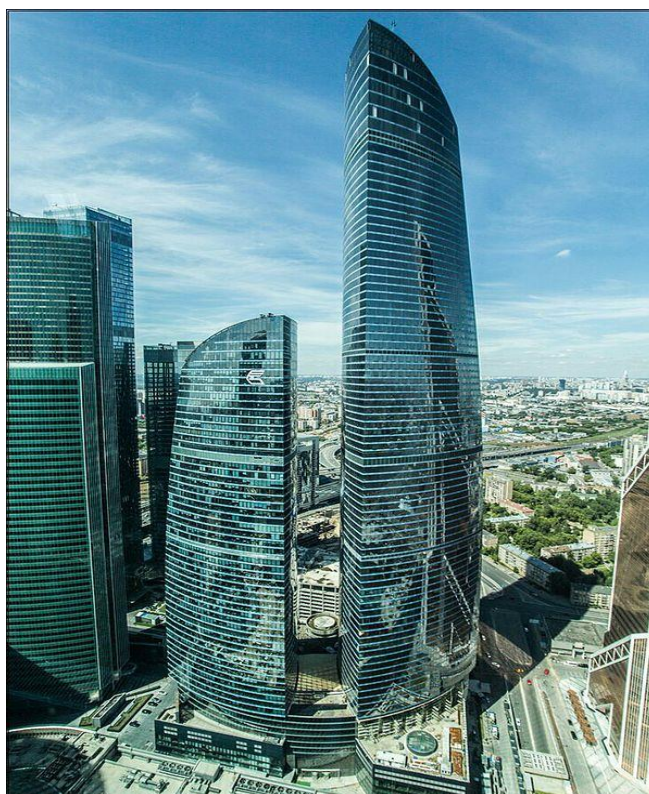
Рис. 3. Башня «Федерация» («Запад» – 243 м, «Восток» – 374 м, 2003 – 2017 гг.).
