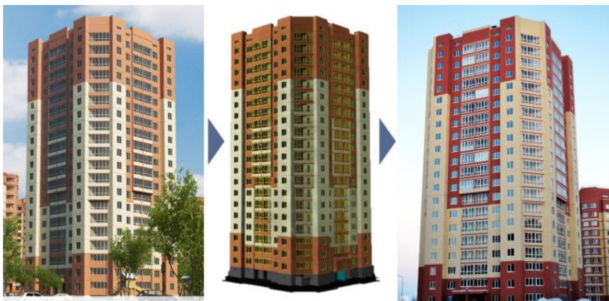
Рис. 1. 20-ти этажный жилой дом со встроенными нежилыми помещениями на 1-м этаже.
