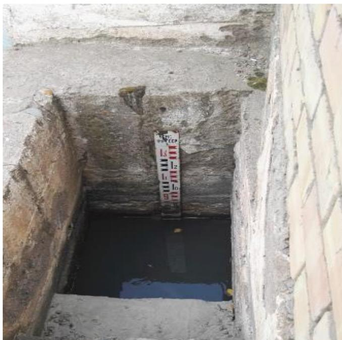
Рис. 2. Успокоительный колодец на гидропосту «Аламедин».
